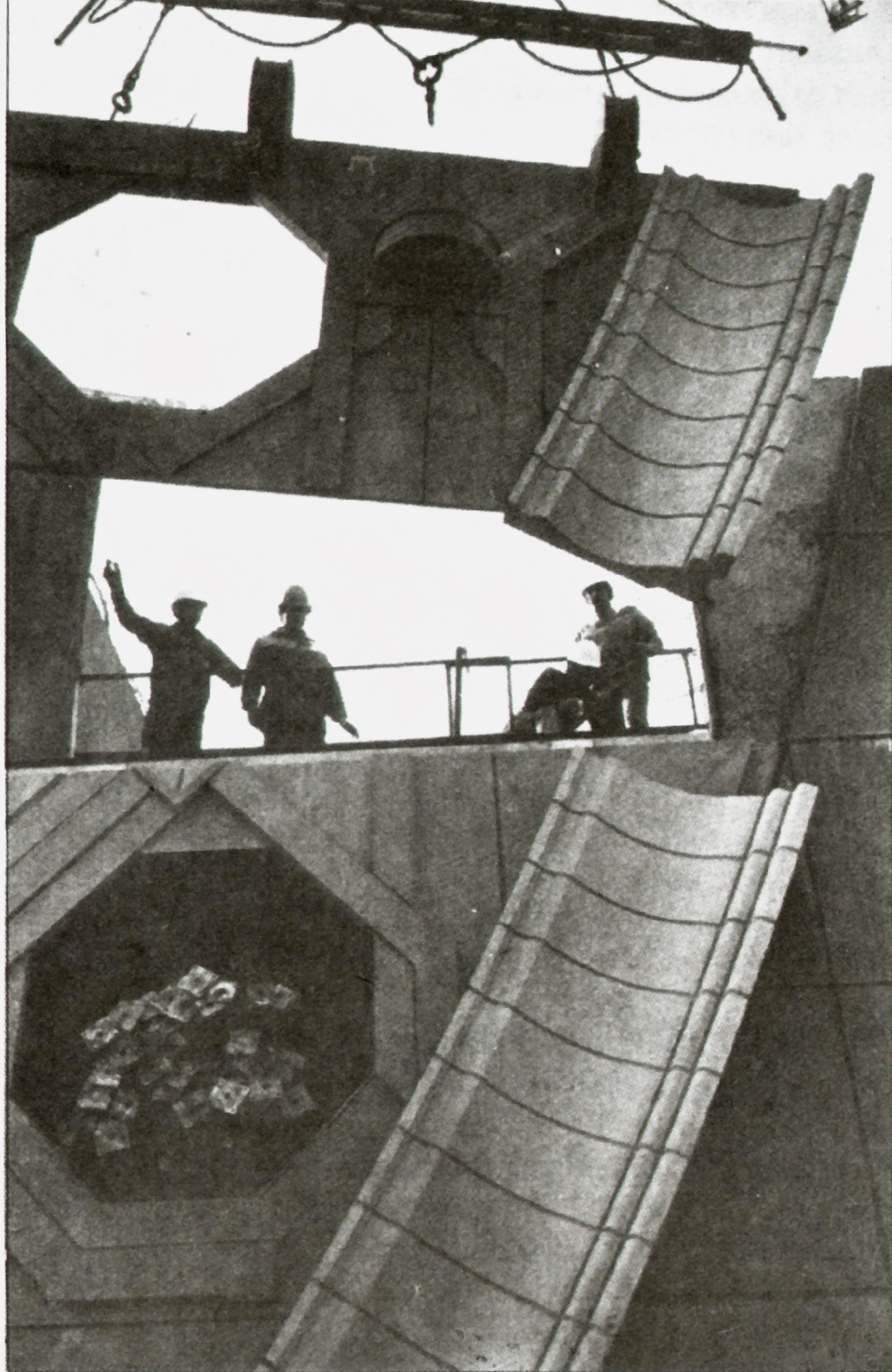
Operaciones de montaje de los elementos prefabricados.
